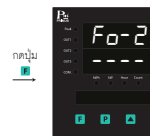
แสดงค่า Previous Fault Output 2
